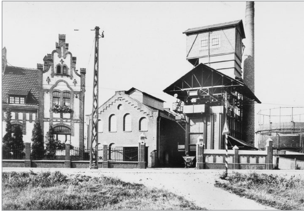
Abb. 10 Die Moerser Gasanstalt 1925 an der Uerdinger Straße.
