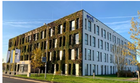
Abb. 3 Enni - Betriebs- und Verwaltungsgebäude am Jostenhof 2021 (2022).
