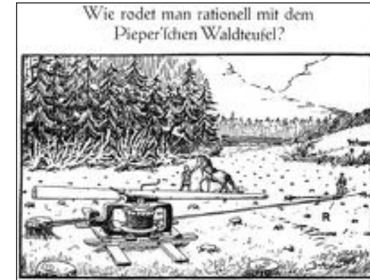
Der Piepersche Waldteufel: Baumstumpf-Rodemaschine
